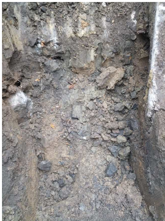
Foto 4: Spodní část bagrované sondy BG4. S patrnou sanací podloží pomocí bet. prážců.
